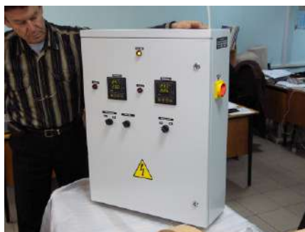
Щит управления системой отопления и ГВС
